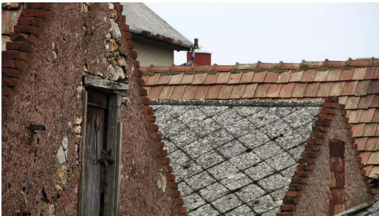
Melléképületek oromfala padlásfeljáróval
