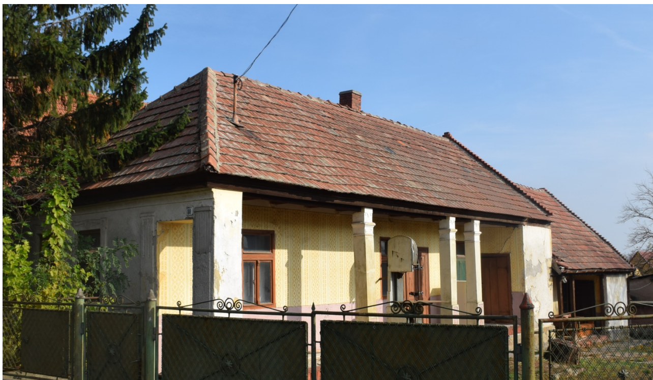
Tornácos népi jellegű lakóház oszlopfős pilaszterekkel, falazott tornácoszlopokkal. A melléképület a ház folytatásaként épült meg.
